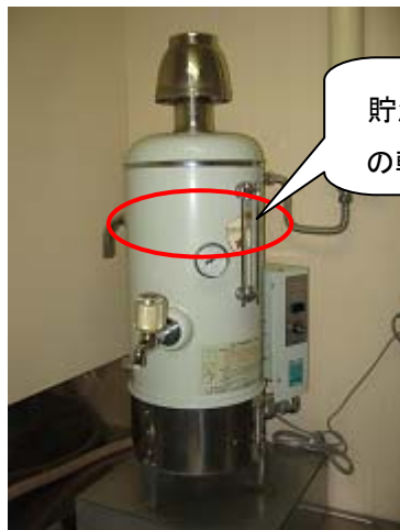
事例7：転倒防止措置不良
